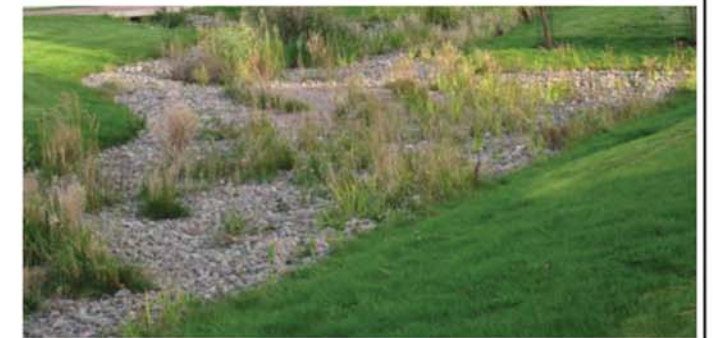
Hulevesipainanteet rakennetaan loivareunaisiksi. Pohjan katteena käytetään someroa tai soraa ja painanteisiin istutetaan kosteutta kestävää kasvillisuutta.
