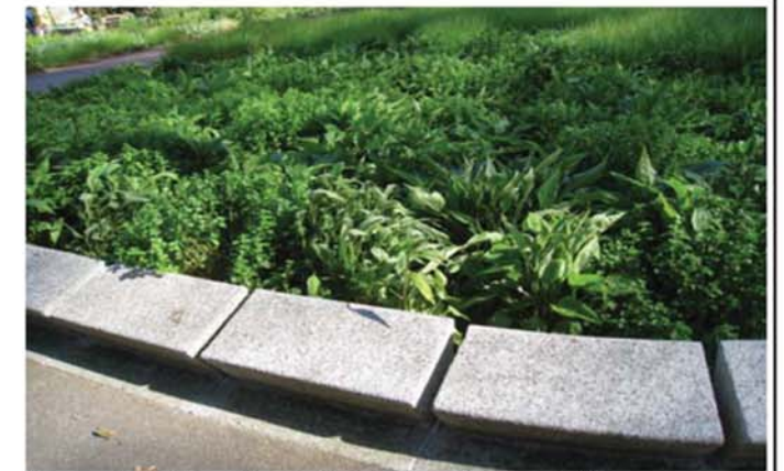
Reunarakenteilla voidaan ohjata hulevesiä painanteisiin.
