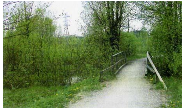
Mätäoanlaakson nykyinen kevyen liikenteen ylityskohta sijoittuu lähelle tulevaa Kehä II:n sijaintia sen pohjoispuolelle. Silta voidaan haluttaessa säilyttää jatkossakin.
