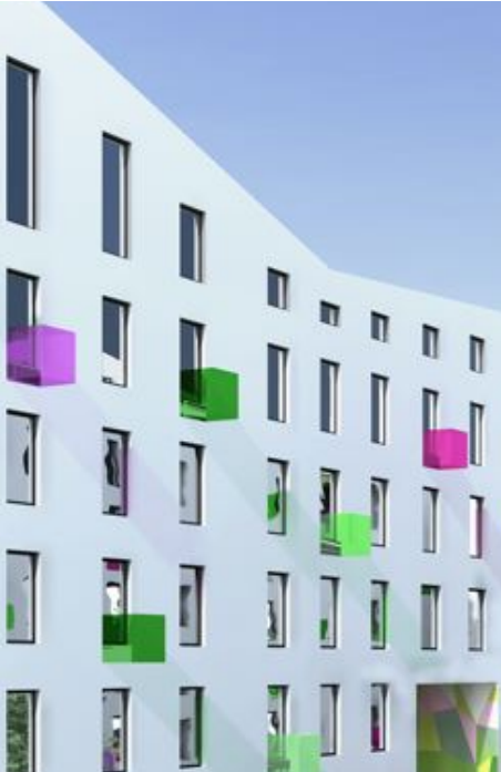
Kuva 2. Sisäpihan ilme on vaalea ja katujulkisivua kevyempi. Systemaattista ikkuna-aukotusta rikkoivat värikkäät, satunnaisesti sijoitetut pienet ulokeparvekkeet / ranskalaiset parvekkeet. (Kuva: L Arkkitehdit Oy)
