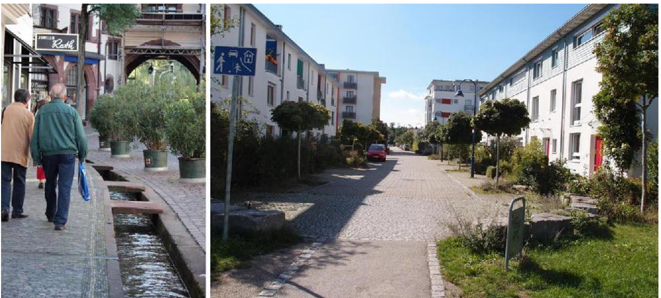
Kuvat 97-98. Kaupunkimainen hulevesikanava sekä hulevesiä imeyttävä pihakatu.
