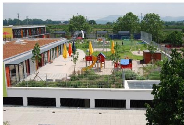
Esimerkki päiväkodista, joka sijoittuu pysäköintihallin päälle. Piha on rakennettu hallin katolle.
