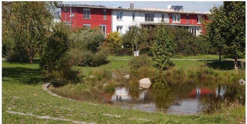
Kuvat 94-95. Viherkatto vähentää muodostuvan huleveden määrää ja hulevesiallas viivyttaa hulevesiä.
