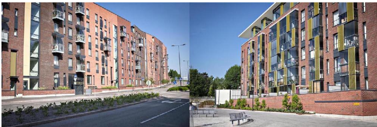
Kuvat 19-20. Uutta asuinkerrostalorakentamista junaradan varrella (Martinmuuri)
