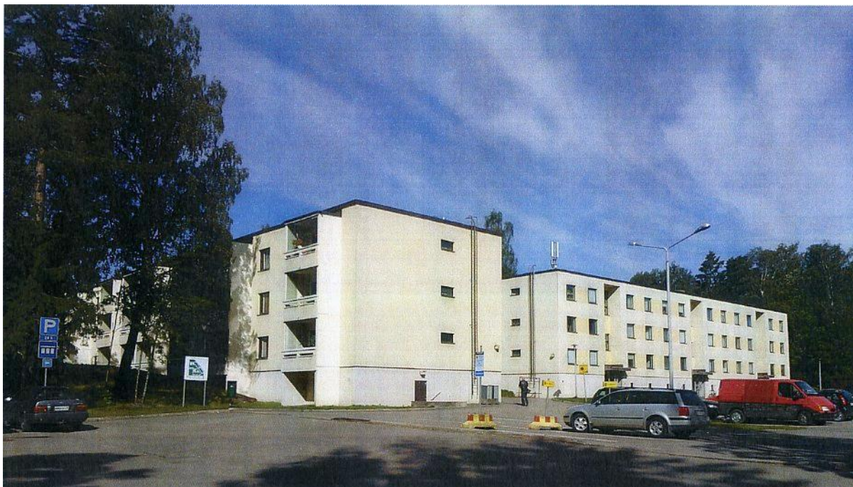
Näkymä Laajaniitynkujan kääntöpaikalta. Purettavaksi esitetty talo oikealla.
