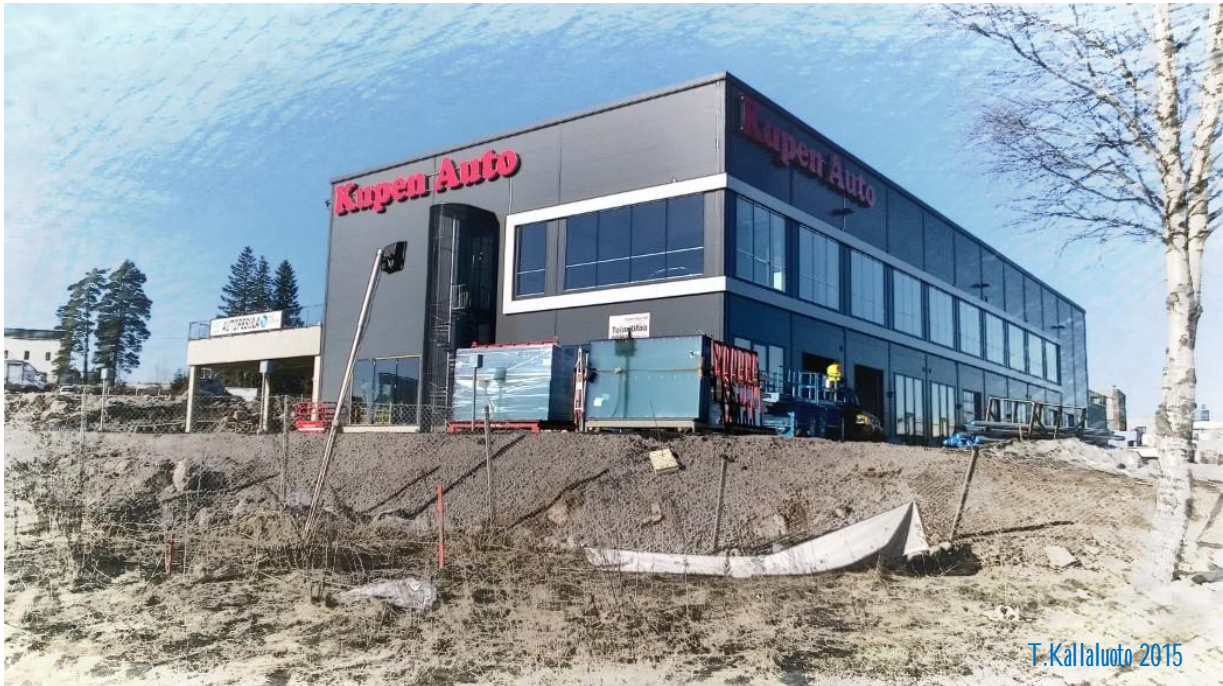
Talo oli rakenteilla maaliskuussa 2015, näkymä Kehä III:lle.
