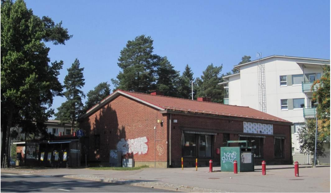
Muutostontilla sijaitseva myymälärakennus kesällä 2014.
