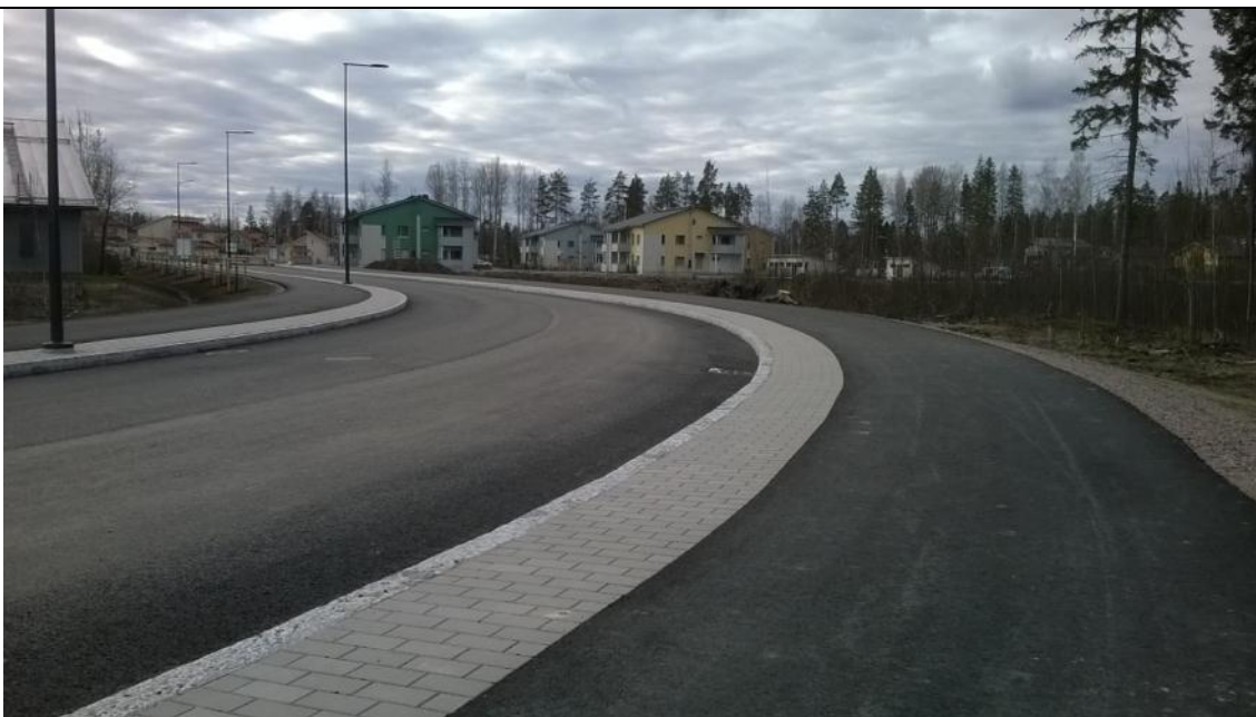
Lipputie on rakennettu valmiiksi. Näkymä pohjoisen suuntaan.
