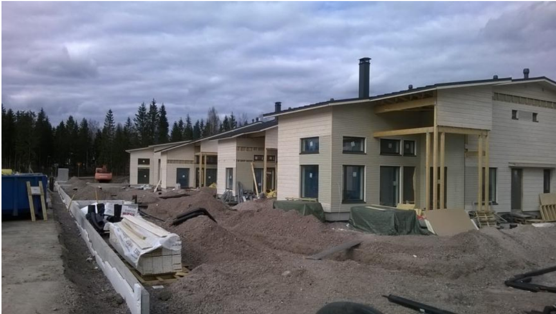
Lipputie 8:n rakennuksia työmaavaiheessa huhtikuussa 2015.
