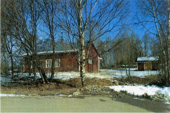
Bygård Vetokujan käänköpaikan suunnasta.
