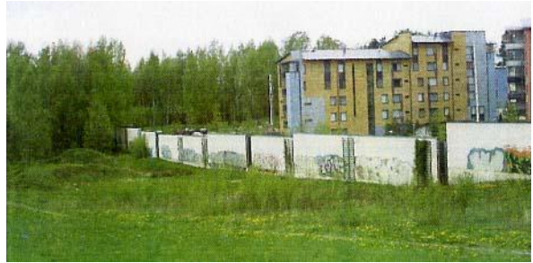
Vaskipellon nykyiset Kehä II:n linjauksen suuntaiset autokatokset toimivat meluseininä. Katosten on suunniteltu jatkuvan eteenpäin Kehä II:ta seuraten.
