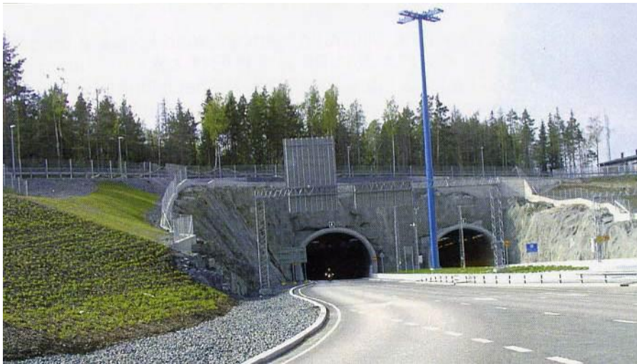
Esimerkki samantyyppisestä tunnelin suuaukosta kuin Honkasuon tunnelin länsipäässä: Kehä III:n Vuosaaren tunnelin eteläpää. Tiehallinto 2008.
