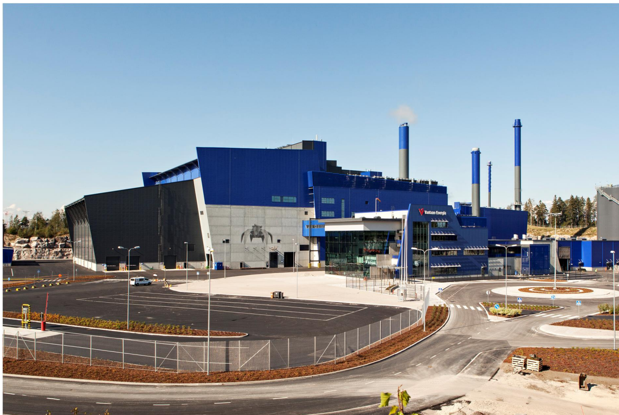
Vantaan Energia Oy, jätevoimala syyskuussa 2014. Kuvaaja Olli-Pekka Orpo.
