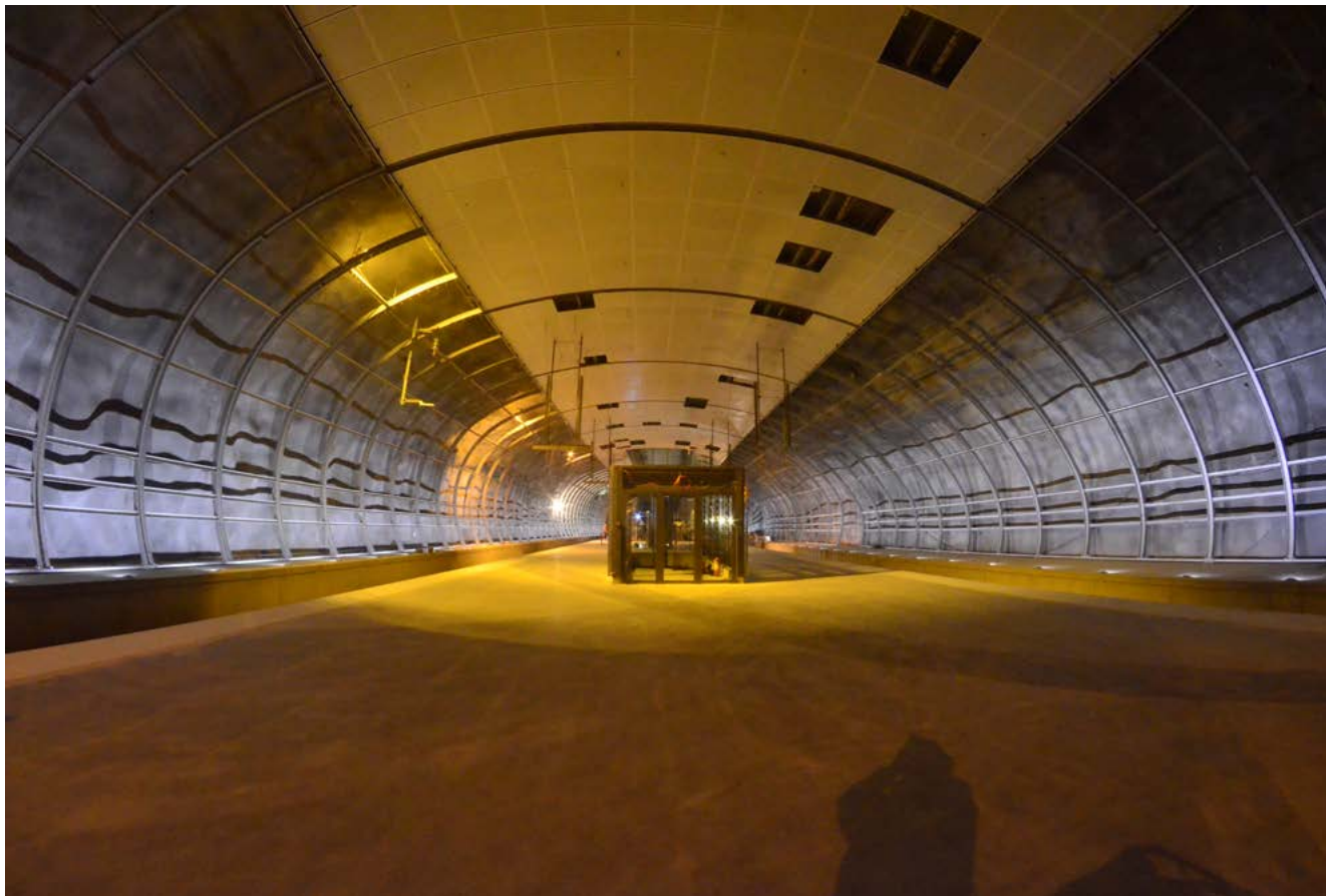
Kuva. Kehäradan asemat valmistuvat yksi toisensa jälkeen.
