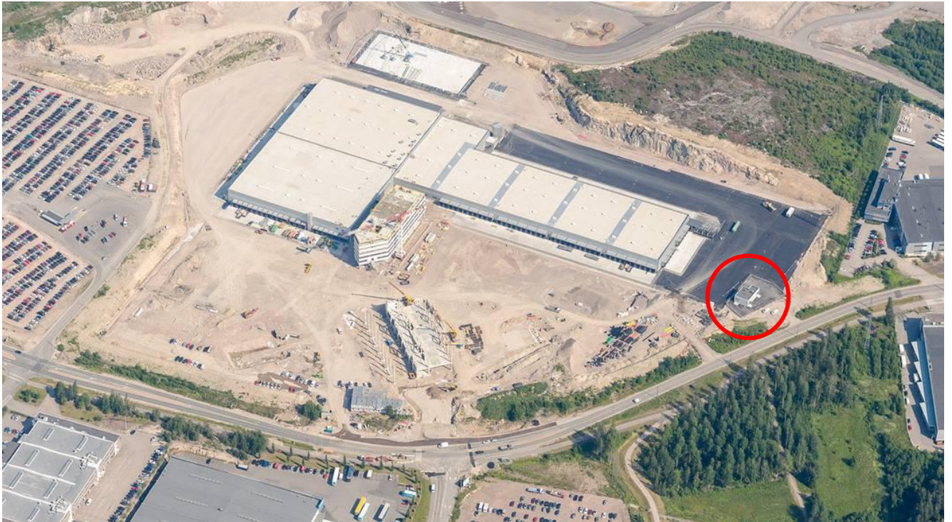
Ilmakuva rakennusvaiheesta (2014). ○ Kuilurakennus.
