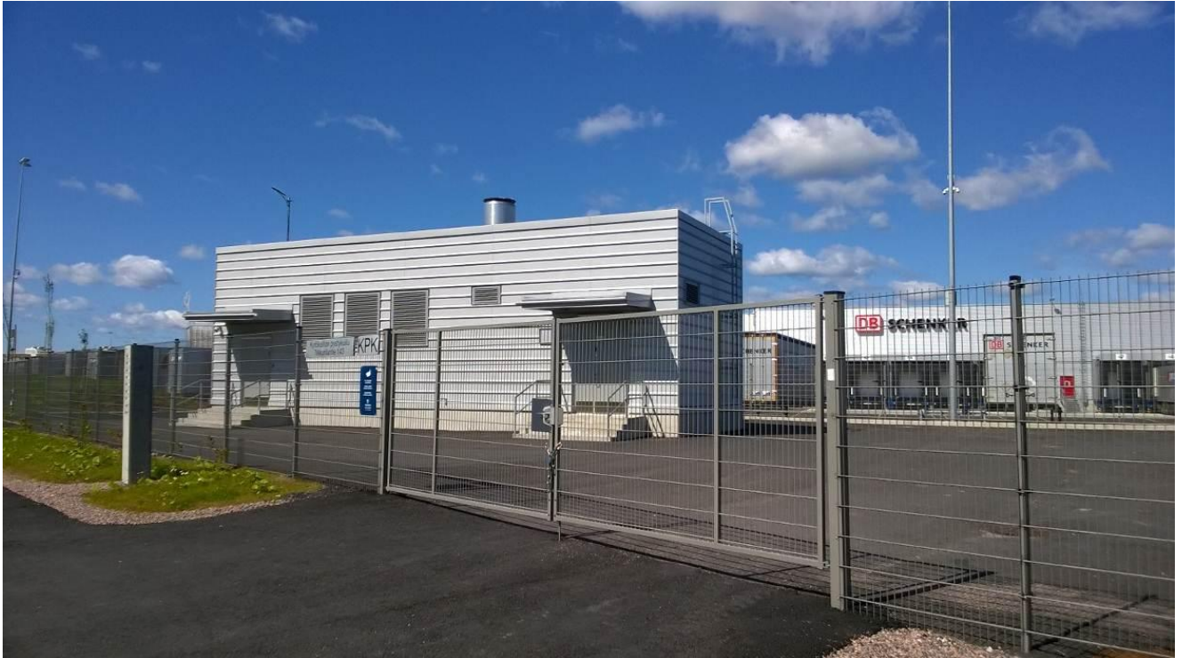
Kehärata ja sen kuilurakennus ovat valmiit.
