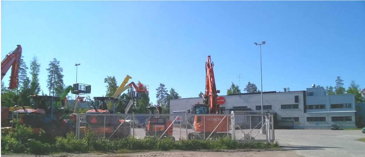
Linkokujan tontin sisäänajo pohjoisesta.
