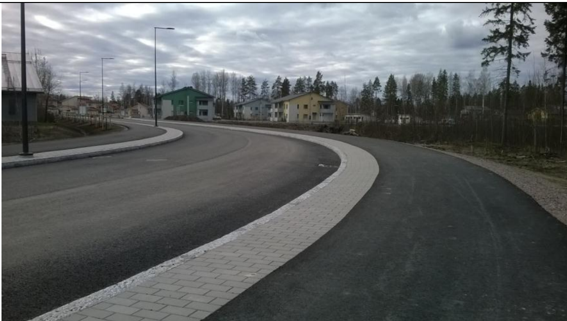
Lipputie on rakennettu valmiiksi. Näkymä pohjoisen suuntaan.
