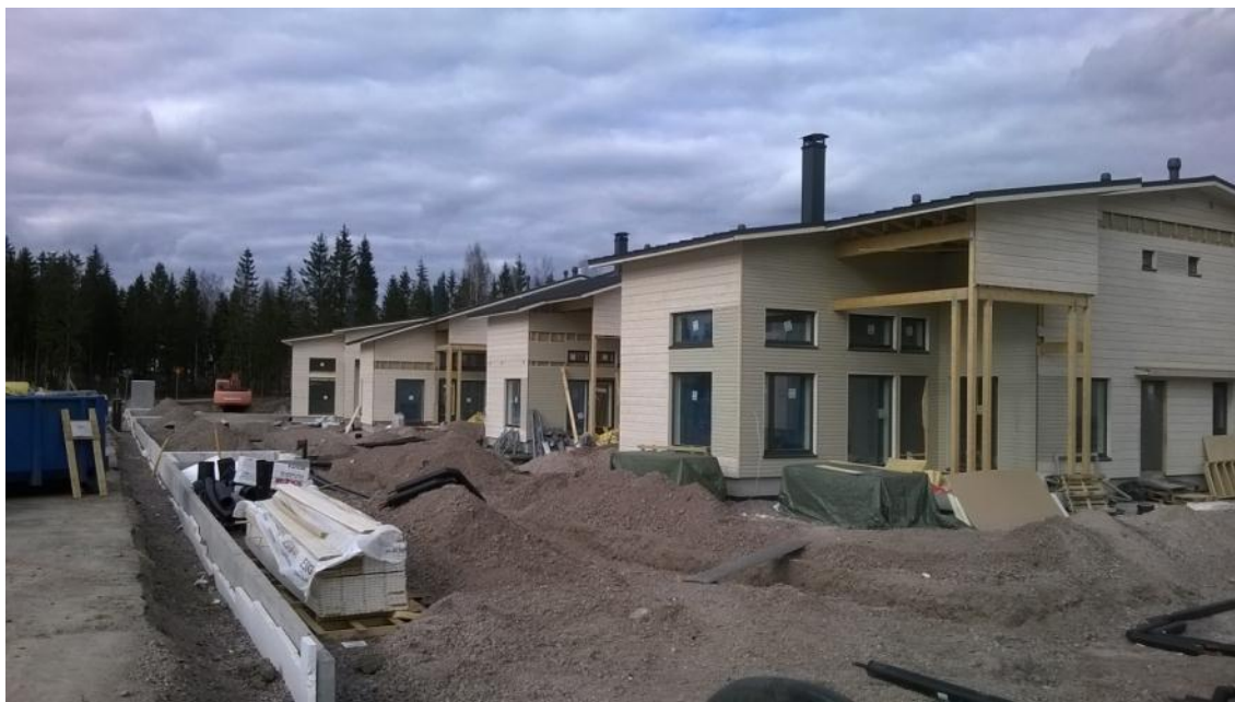
Lipputie 8:n rakennuksia työmaavaiheessa huhtikuussa 2015.
