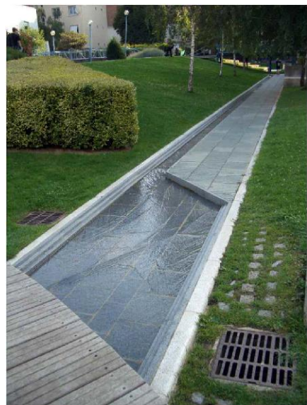
Rakennettu "puomainen" hulevesiä kuljettava kouru, kulkuyhteyksien kohdalle mahdollista tehdä matalia "siltoja"
