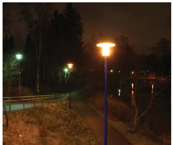
Kuva 29. Keravanjoen varren valaistuksessa on nykyisin käytetty paikotellen erivärisiä pylväitä, mutta myös eri valonlähteitä. Tavoitteena valaistuksessa lämmin valkoinen valo. Nykyinen suurpainenatrium ei toista riittävästi ympäröiviä värejä, vaan tekee jokiympäristön tunnelmasta tunkkaisen.
