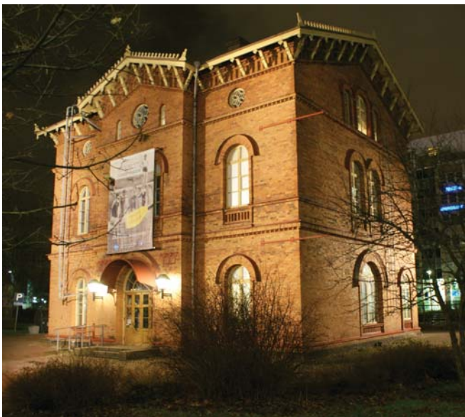
Kuva 33. Tikkurilan museona toimiva vanha asemarakennus on nykyisin tasaisesti valaistu useammasta suunnasta. Sisäänkäyntejä korostavat perinteiset lyhdyt.
