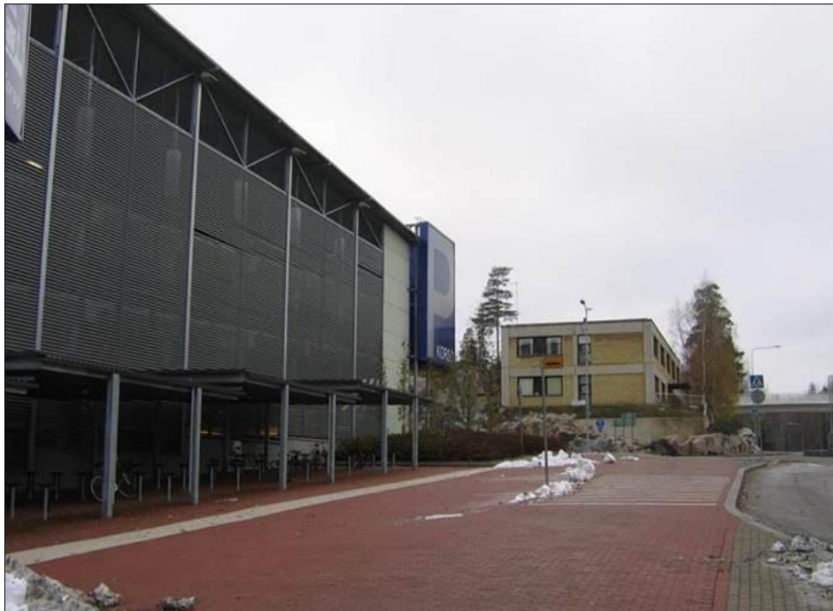
Vasemmalla p-talo ja taustalla purettava rakennus.
