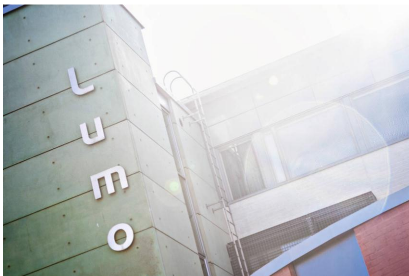
Lumon lukion talotekniset korjaustyöt valmistuivat vuonna 2015
