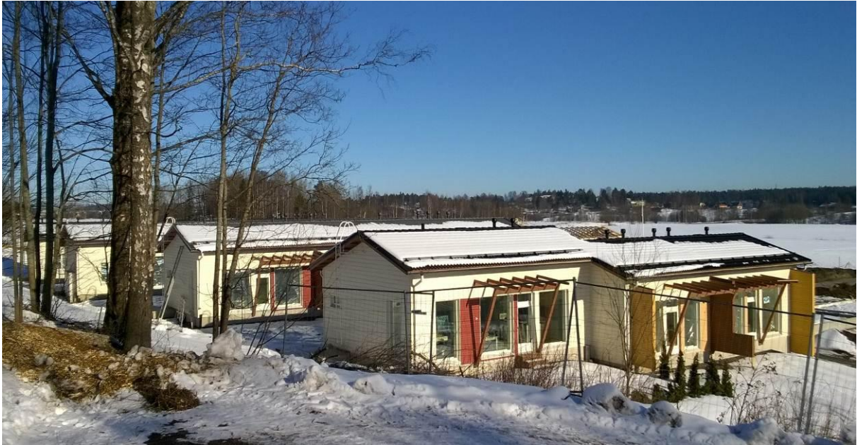
T2H:n rakentamista Viiripolulta nähtynä.
