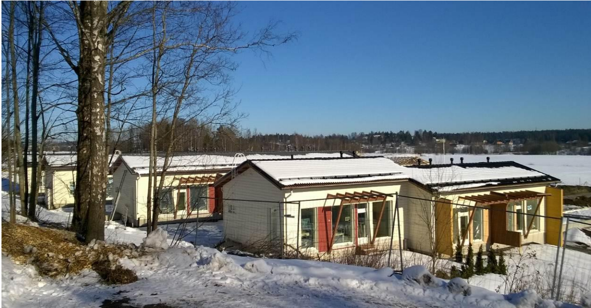
T2H:n rakentamista Viiripolulta nähtynä.
