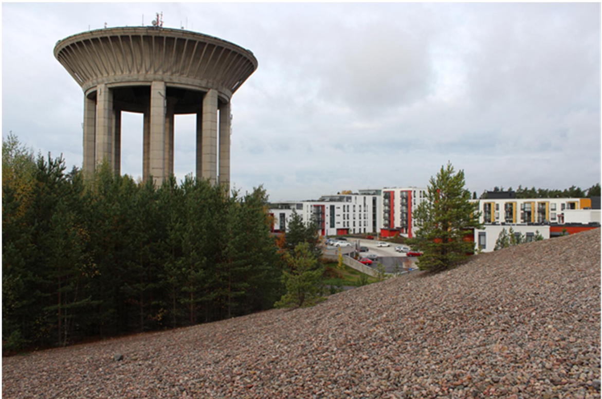
Simonkylän puolella sijaitseva nykyinen Hiekkaharjun vesitorni näkyy maisemassa kauas.
