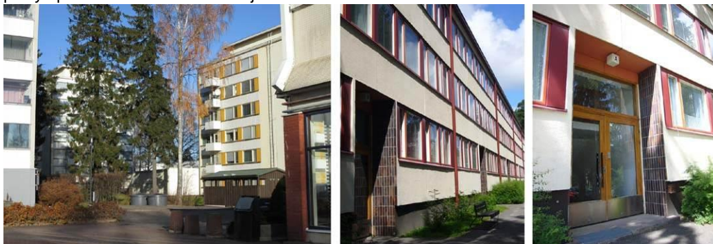
Kuvat 6-8. Kaivokselan rakennuskantaa
