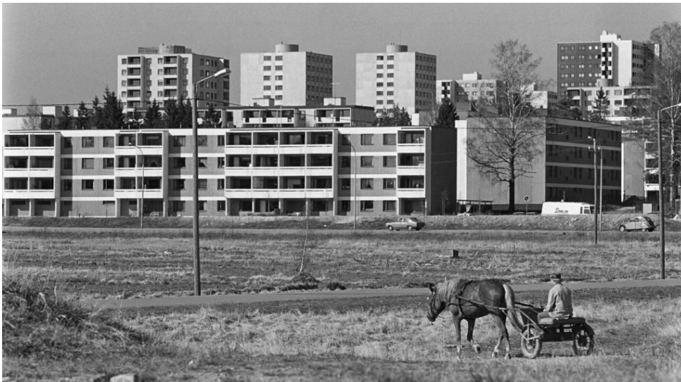
Havukosken lähiö rakennettiin Koivukylän pientaloalueen läheisyyteen 1970-luvulla. Havukoski on Vantaan ensimmäinen lähiö, joka on suojattu asemakaavassa. Kuva: Matti Luumi / Vantaan kaupunginmuseo.
