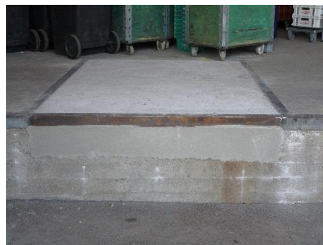
Kuva 1. Lastauslaiturilla oleva metallipintainen nostolevyalue ennen ja jälkeisen betonitäytön
