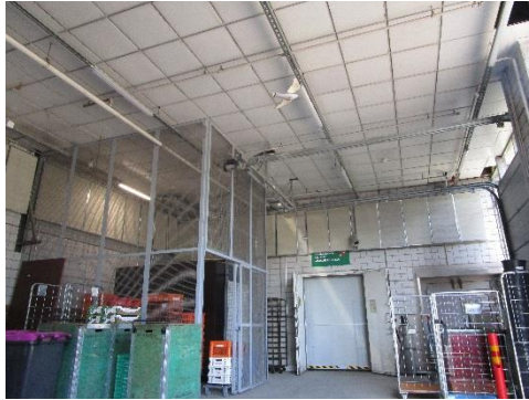
Kuva 2. Akustiikkalevyjen sijoitus takaseinän ja sivuseinän yläosiin
