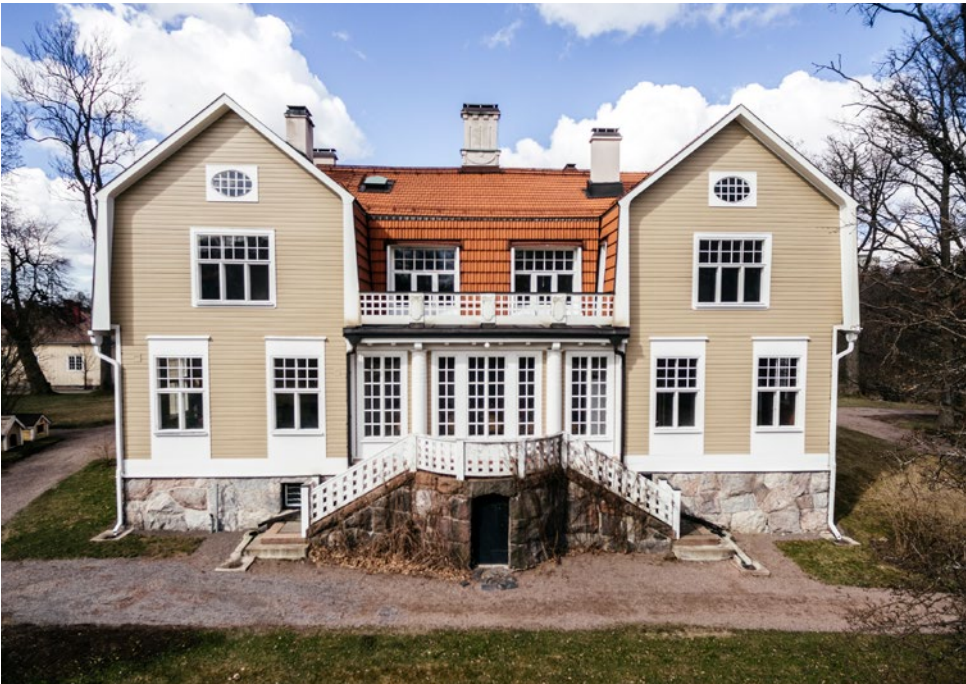
Håkansbölen kartano Hakunilassa odottaa sisäremonttia. Alueen talousrakennukset kunnostetaan vuoden 2020 aikana. Kuva: Antti Yrjönen / Vantaan kaupunginmuseo.
