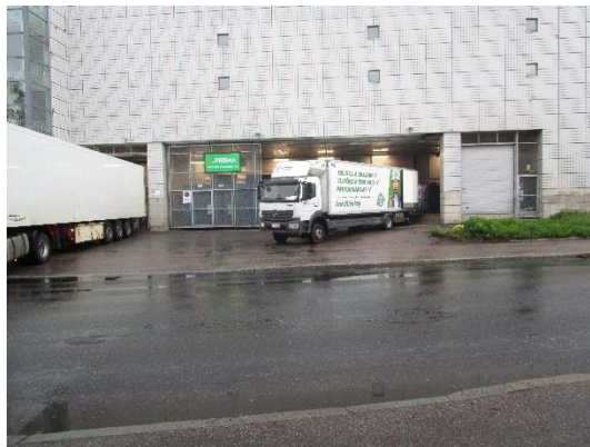
Kuva 3. Kuorma-autoja tyhjentämässä tavaraa.
