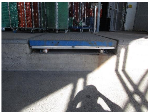
Kuva 1. Lastauslaiturilla oleva metallipintainen nostolevyalue ennen ja jälkeisen betonitäytön
