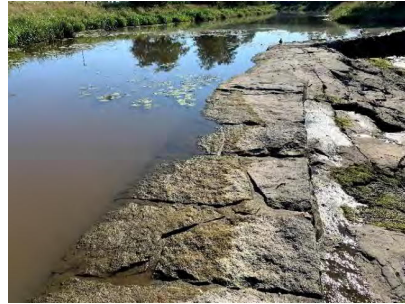
Kuva 3. Ylivuotopadon luonnonkivirakenteita
