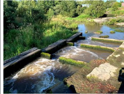
Kuva 4. Betonirakenteinen kalaporras
