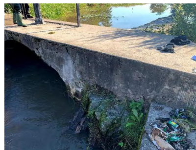
Kuva 2. Varsinainen patorakenne on teräsbetonia
