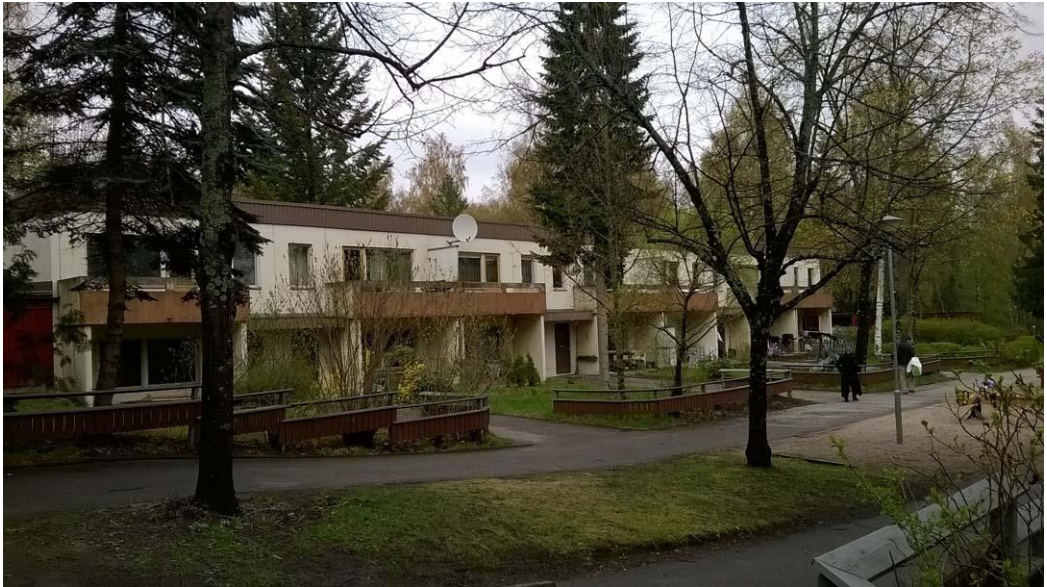
Kuva 5. purettavat 2-kerroksiset asuinrakennukset
