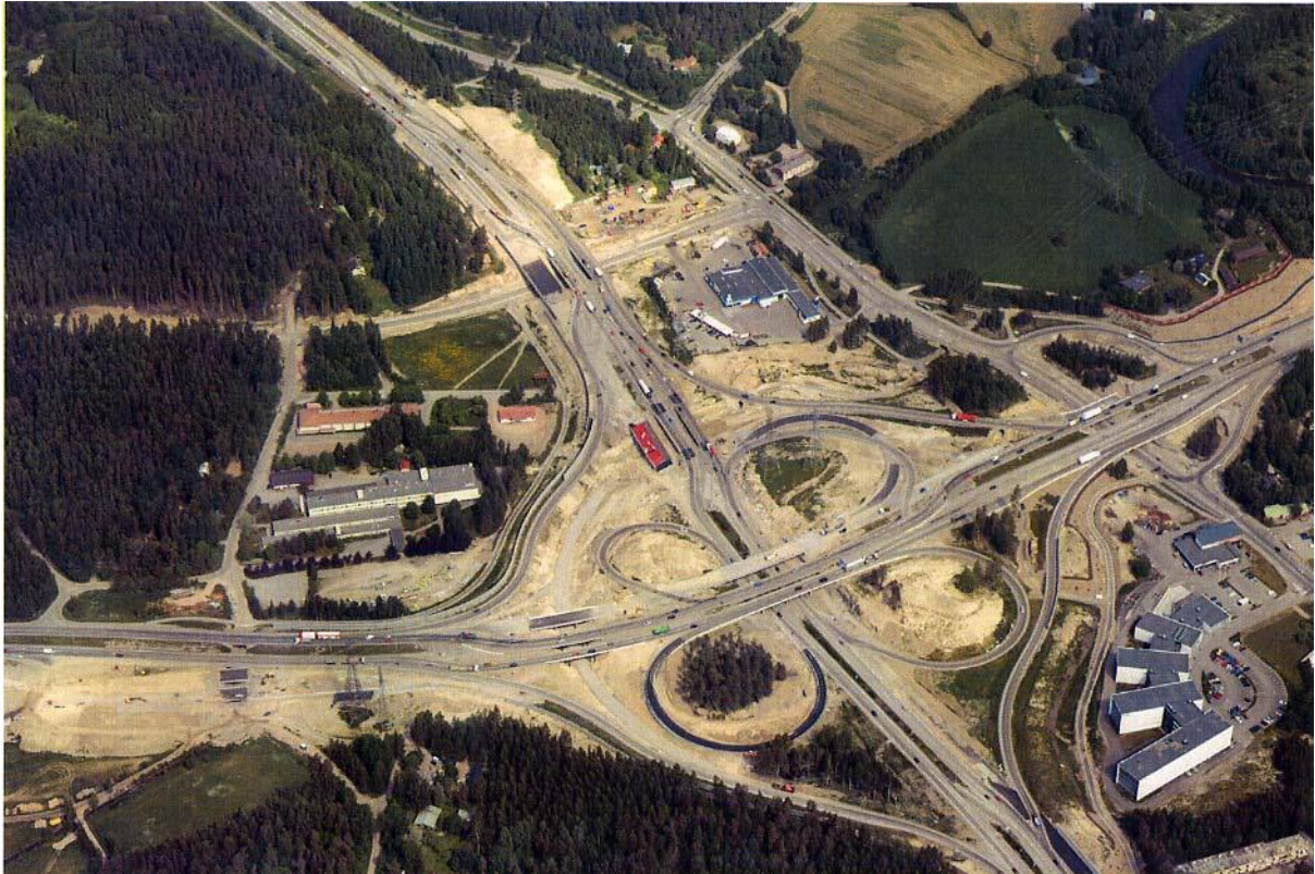
Kehä III:n ja Hämeenlinnanväylän liittymän rakennustyö kesällä 2011.
