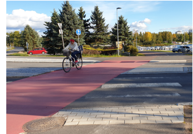
Kuva 16. Baanoilla suositellaan käytettäväksi liittymäalueilla kivisirotepinnoitetta, jonka punainen väri on huomattavasti kirkkaampi kuin värillisen asfaltin (kuva Oulusta).
