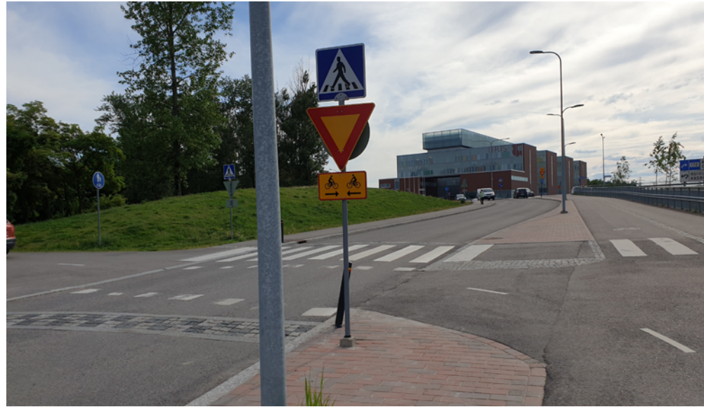
Kuva 20. Korotettu suoja- tie ja pyörätien jatke pyöräilyn pääreitillä (kuva Helsingistä).
