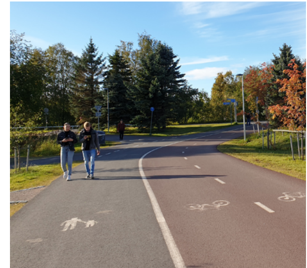
Kuva 17. Baanoilla käytetään punaista päällystettyä, pyöräliikenteen suuntia erottavaa keskiviivaa ja noppakiviraitaa jalankulun ja pyöräilyn välissä (kuva Oulusta).
