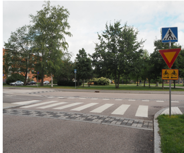
Kuva 23. Korotettu suojatie ja pyörätien jatke sivukadun liittymässä Peltolantiellä.
