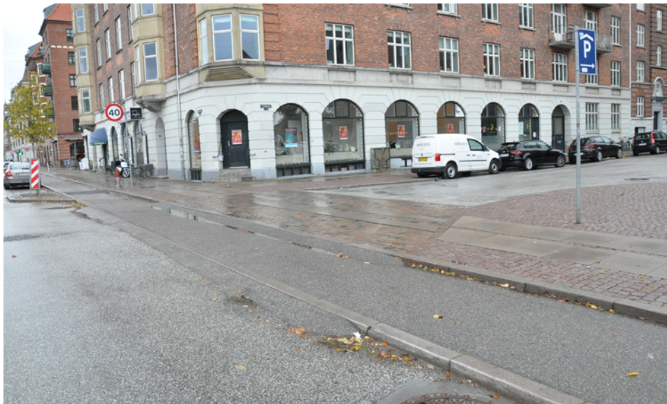
Kuva 22. Jalankulku- ja pyörätien rakenteen jatkaminen korotettuna sivukadun ajoradan yli antaa autoilijalle vahvan visuaalisen viestin väistämiselvöllisyydestä ja on miellyttävä kävelijöille ja pyöräilijöille (kuva Kööpenhaminasta).
