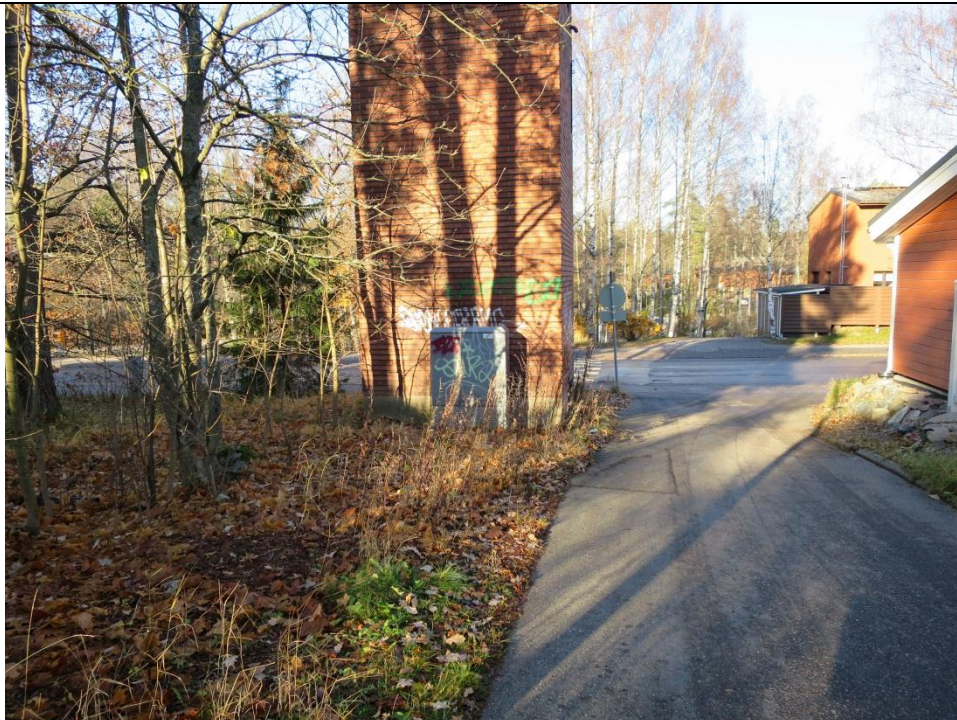
Tornimuuntamo ja sähkökaappi sekä Lintukallionpolku Kivimäentielle päin. MJ 6. 11. 15.
