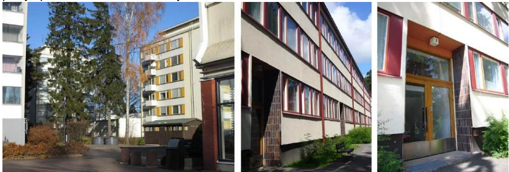
Kuvat 6-8. Kaivokselan rakennuskantaa
