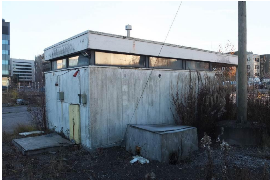
Portinvartijarakennuksen takaosa koillisesta kuvattuna (Minna Koskinen, syksyllä 2015)
