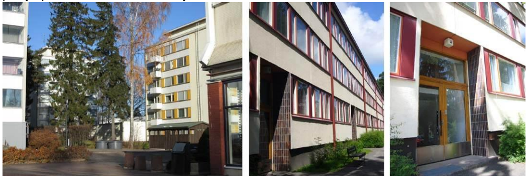
Kuvat 6-8. Kaivokselan rakennuskantaa
