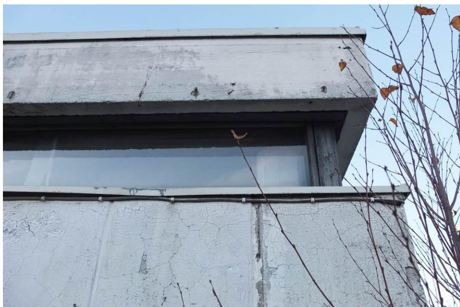
Yksityiskohta rakennusta kiertävästä nauhaikkunasta ja ulkoseinän pystysuuntaisista elementeistä (Minna Koskinen, syksyllä 2015)
