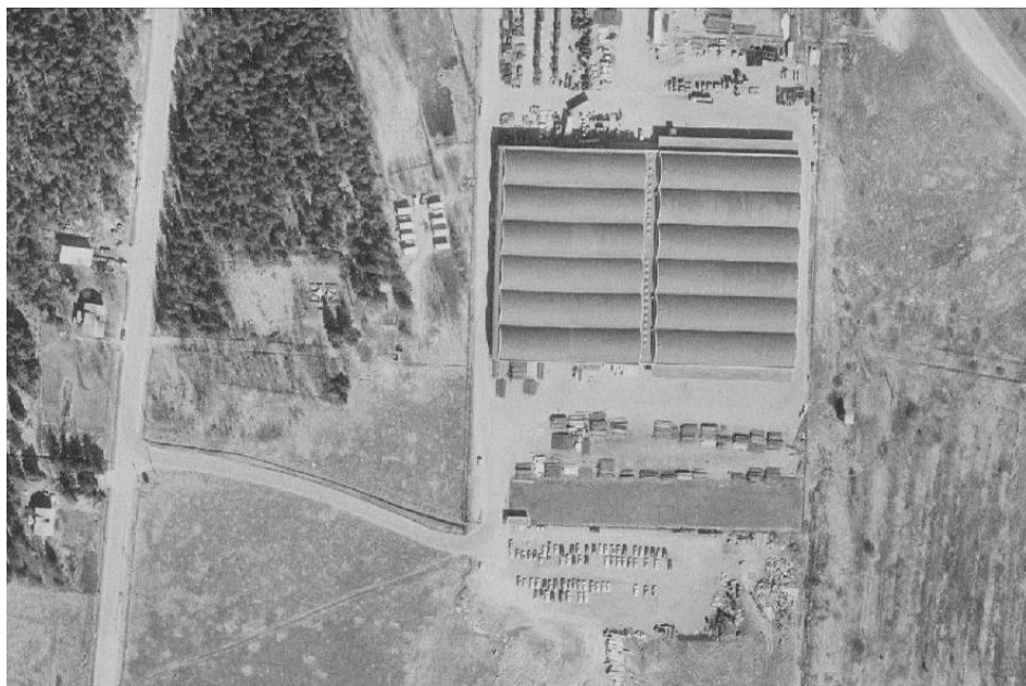
ilmakuva vuodelta 1976: portinvartijarakennus ja siihen kiinteästi liittyvä aita ovat näkyvissä. (Vantaan karttapalvelu)
