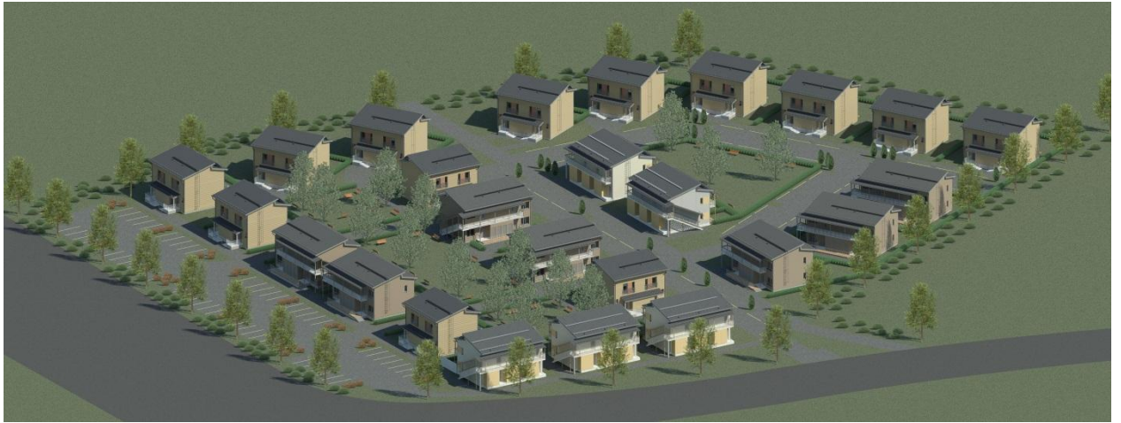
Kaavamuutosalue luoteesta katsottuna, arkkitehti Jorma Toivonen
