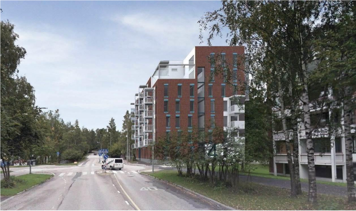
Näkymä etelästä Pähkinärinteentietä pitkin.
