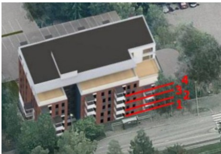
Kuva 2 Talossa vain kolme ja puoli parvekettä katutason yläpuolella.
