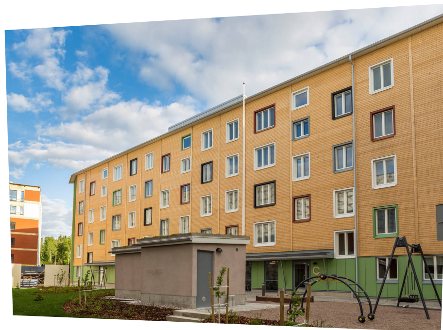
Puurakentamista Kivistössä. Kuvaaja: Sakari Manninen
