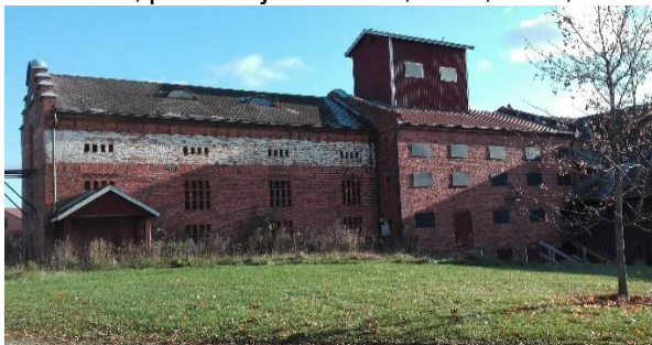
Kuivaamo, puimala ja rehulato, 1920, 1934, 1958 (sr/10)
