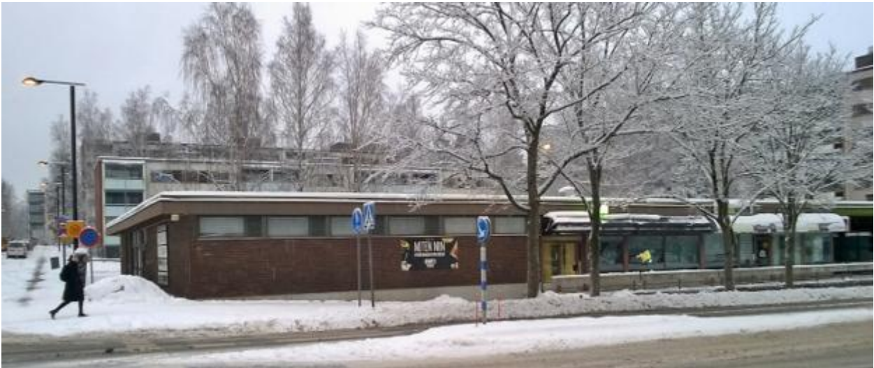
Ostoskeskus Uomatien suuntaan. Vain osa julkisivusta on avointa liiketilaa.
