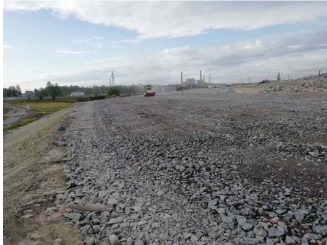
Kuva: esirakentamisvaihe, syksy 2019
