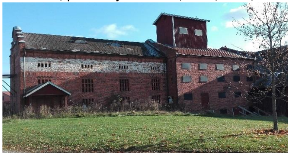
Kuivaamo, puimala ja rehulato, 1920, 1934, 1958 (sr/10)
