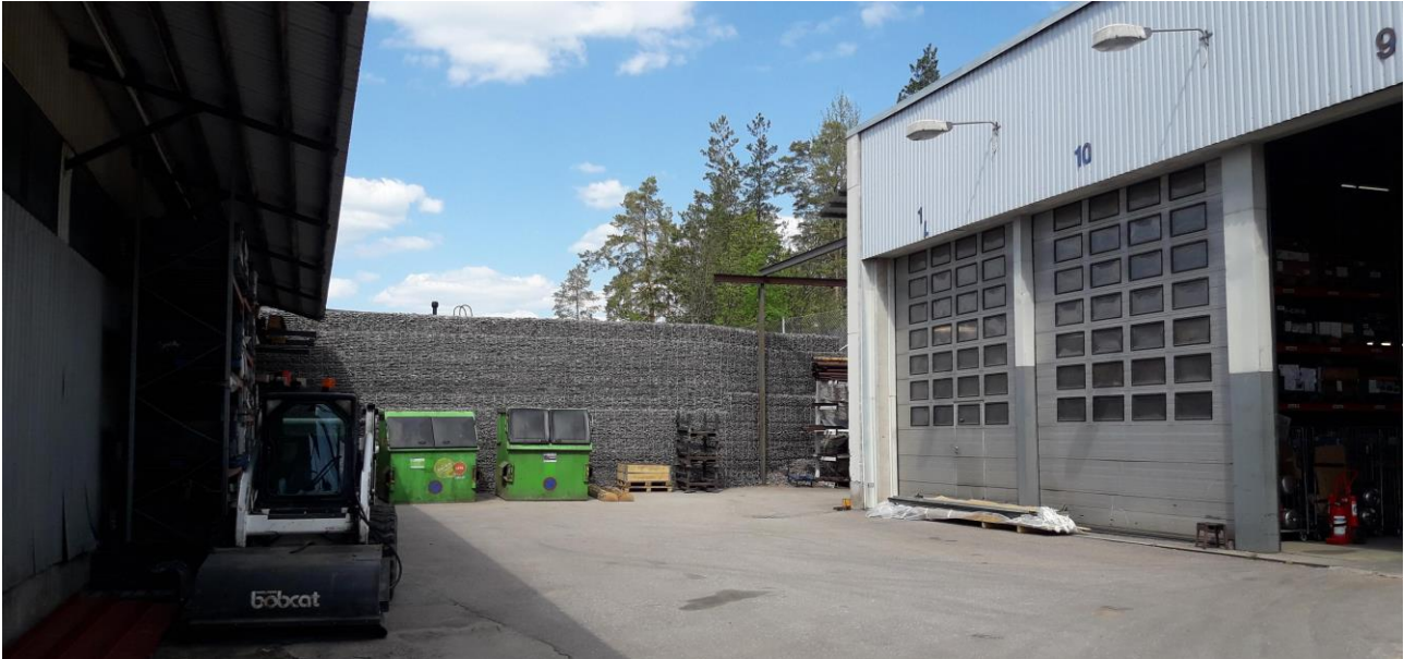
Kuva 1. Kivikoriaitana toteutettu meluaita VTA Tekniikka Oy:n kiinteistön ja Rajatie 3 F paritalon välissä.
