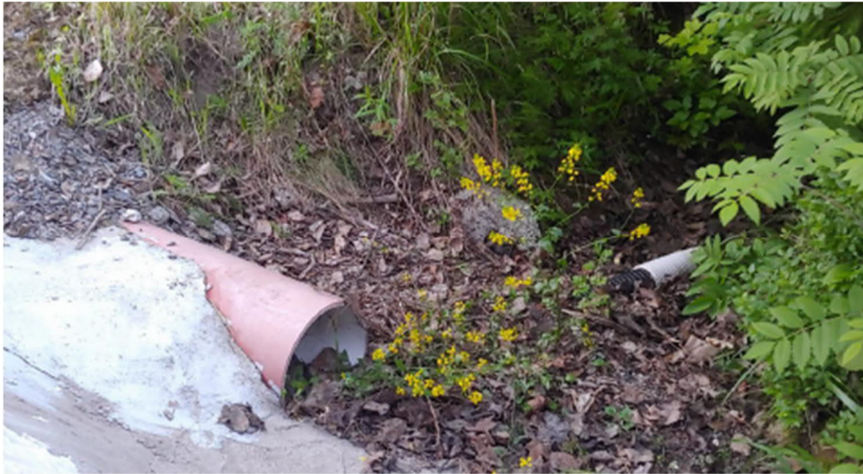
Kuva 3. Putkitetun ojan alkupää Vieteririnne 4:n itäpuolella
