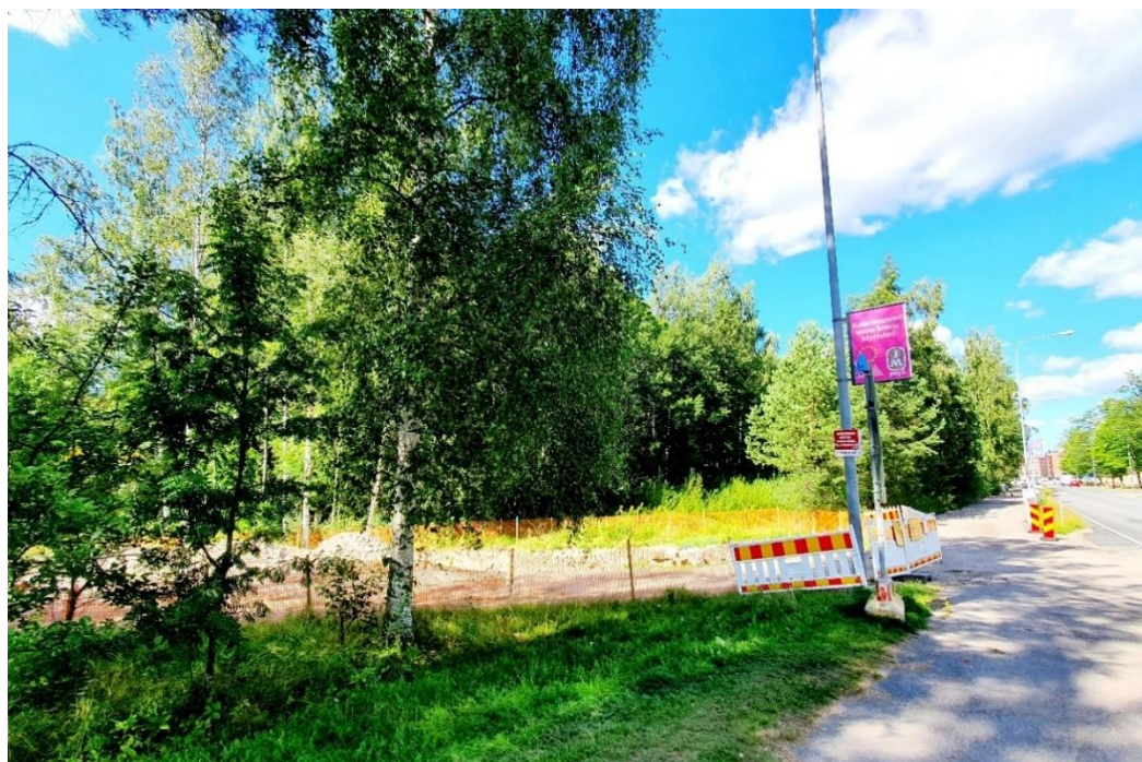
Kuva 3. Näkymä Raappavuorentieltä tontin suuntaan. Tontin laidalta siirretään kaasuputkea, työ valmis marraskuussa 2020. Kuva Saija Lauriala 17.8.2020
