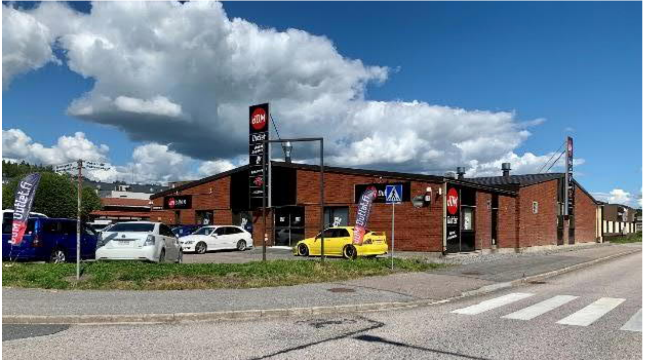
Näkymä tontille Tiilenlyöjänkujan ja Petikontien risteyksestä.
