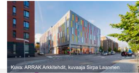
Kuva: ARRAK Arkkitehdit, kuvaaja Sirpa Laaninen
