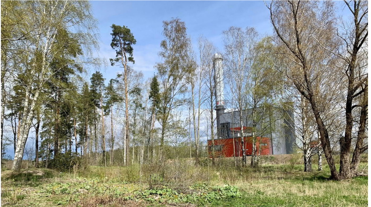
Sähköaseman paikka lämpövoimalan länsipuolella on vanhaa peltoa ja tonttimaata. TKa 17.3.2020
