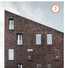
Toimistorakennuksen julkisivun aukotusta korostetaan selväpiirteisellä ikkunadetailloinnilla
