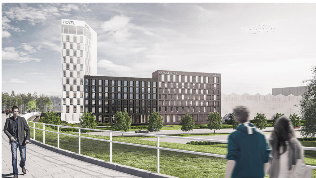
Näkymä Lentoasemantielle. kuva: Arkkitehdit Soini & Horto ja Avarrus Arkkitehdit Oy
