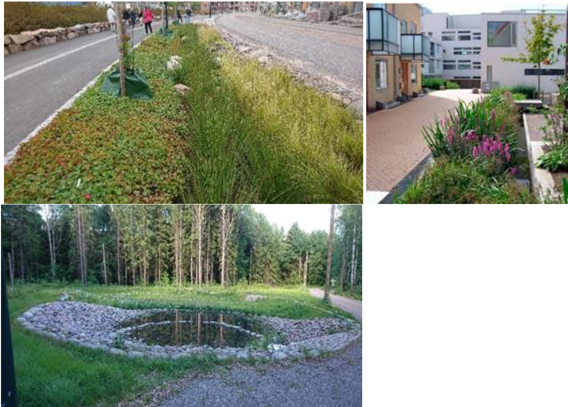
Kuva 48. Katujen hulevesiä pyritään ohjaamaan biosuodattaviin hulevesirakenteisiin istutuskaisioille, joihin mahtuu sekä katupuuistutuksia että kosteutta sietäviä heiniä, saroja ja muuta niittykasvillisuutta. Keskellä esimerkki pihakadun sadeputarhasta. Oikealla esimerkki hulevesien laskeutusaltaasta ja biosuodattuksesta metsäpuutarhassa.
