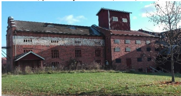
Kuivaamo, puimala ja rehulato, 1920, 1934, 1958 (sr/10)
