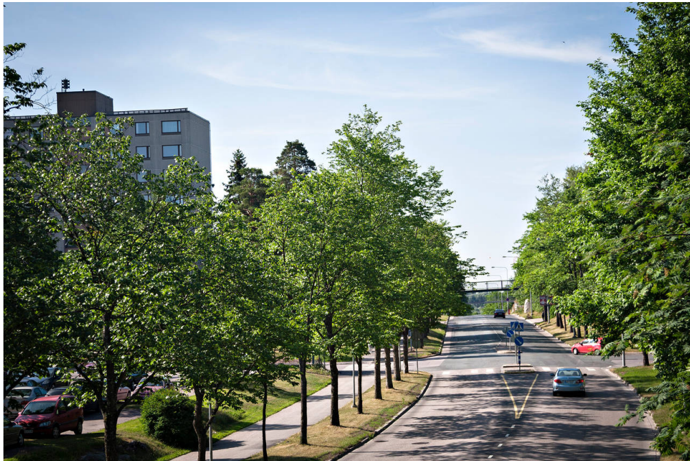
Ylläolevassa kuvassa Hakunilantien kaupunkitaluonnetta. Vhreä katutila rajautuu laajoihin avonaisiin pysäköintialueisiin. Hakunilantien ylittää nykyisellään useita kävelysilloja.
