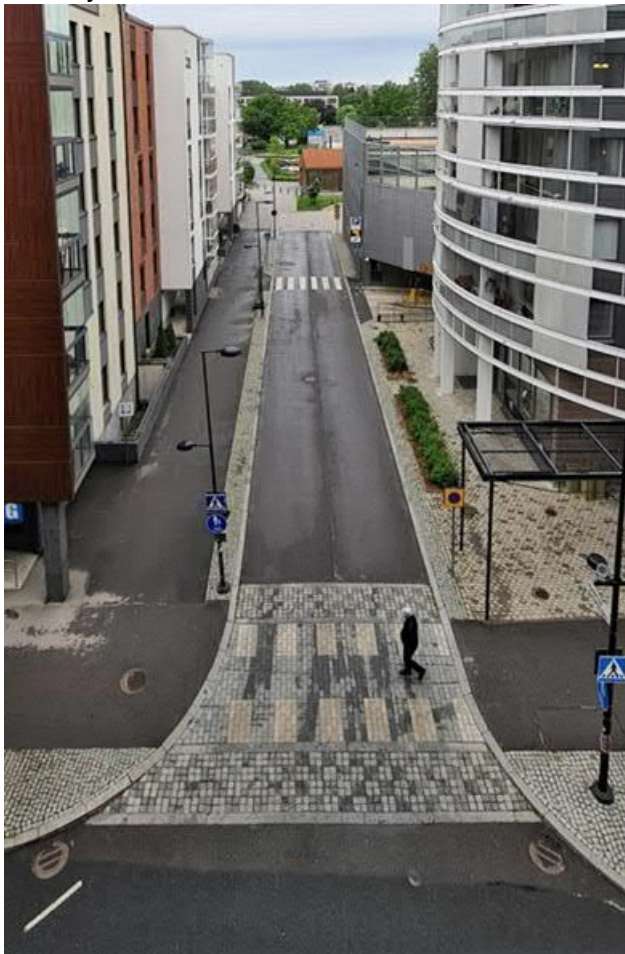
Kuva 1. Suunnittelualueutta Ratakujan kohdalla kesäkuussa 2020 kauppakeskus DIXI:n suunnasta kuvattuna (lähde: Vantaan raitiotie, rakennettavuusselvitys, Ratakujan tunneli Afry Finland 19.4.2021)
